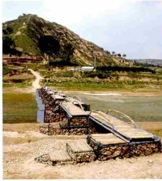
9 基于当地独木桥建构原理设计兴建的毛寺村无止桥
